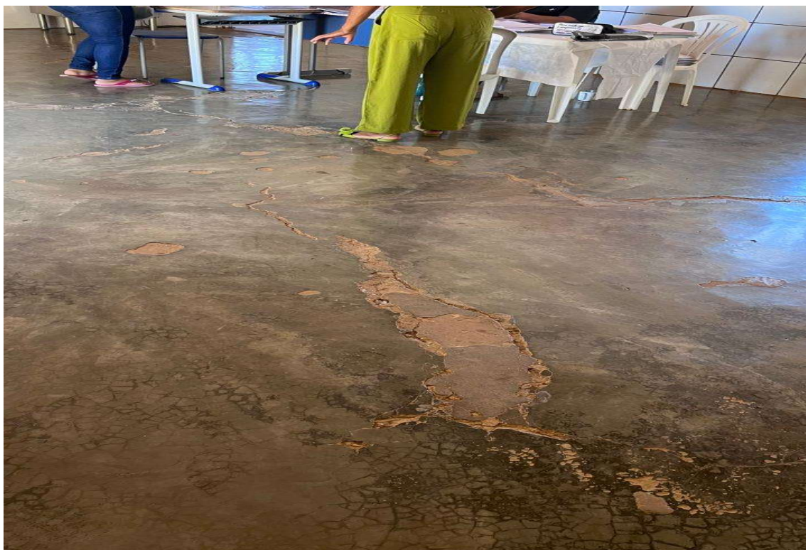
FOTO 03: PISO DE CONCRETO
