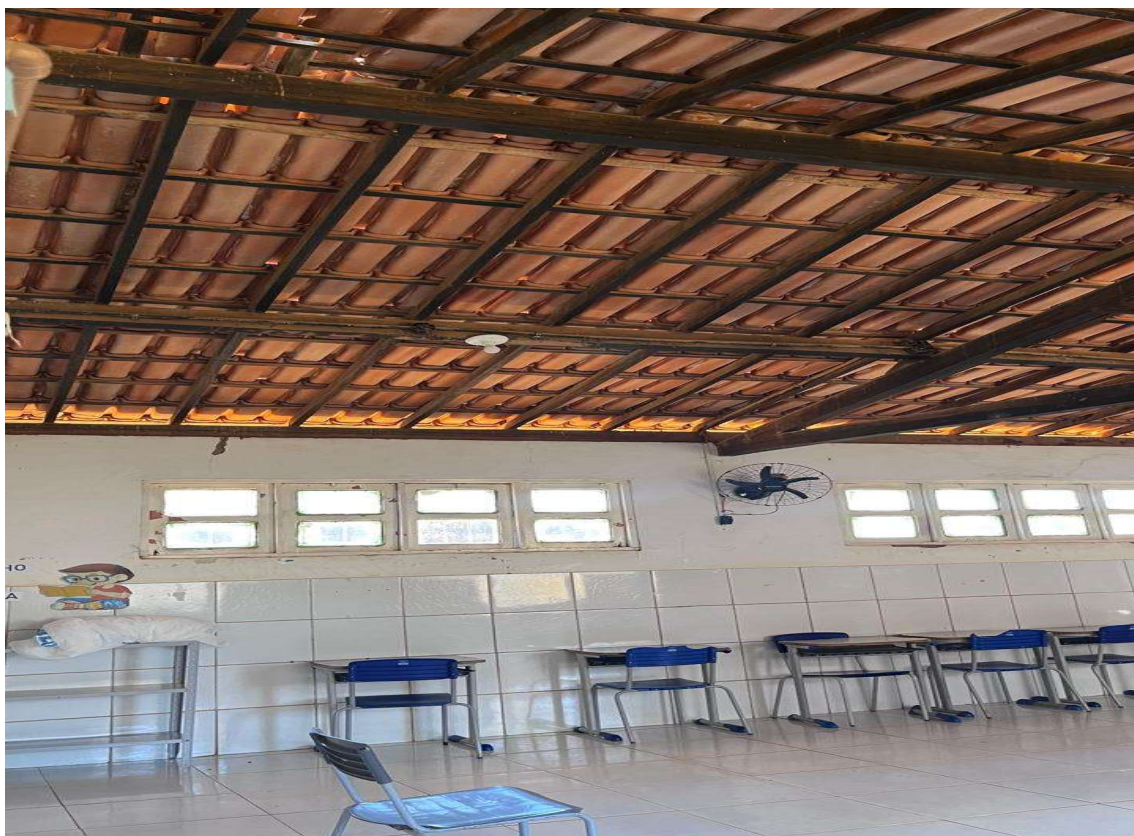
FOTO 11: COBERTURA ( TELHA CERAMICA)
