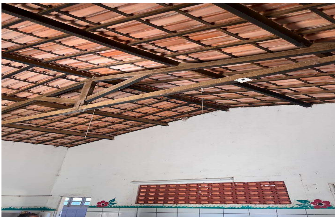
FOTO 12: COBERTURA ( TELHA CERÂMICA)
